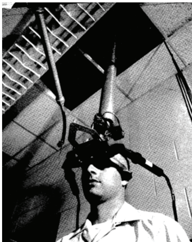
Слика 3. Изглед првог уређаја за проширену стварност Ивана Садерленда
